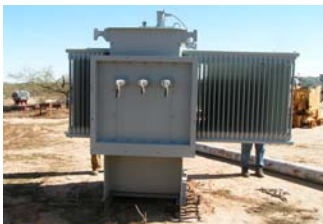
ABB 1000KVA Transformer
